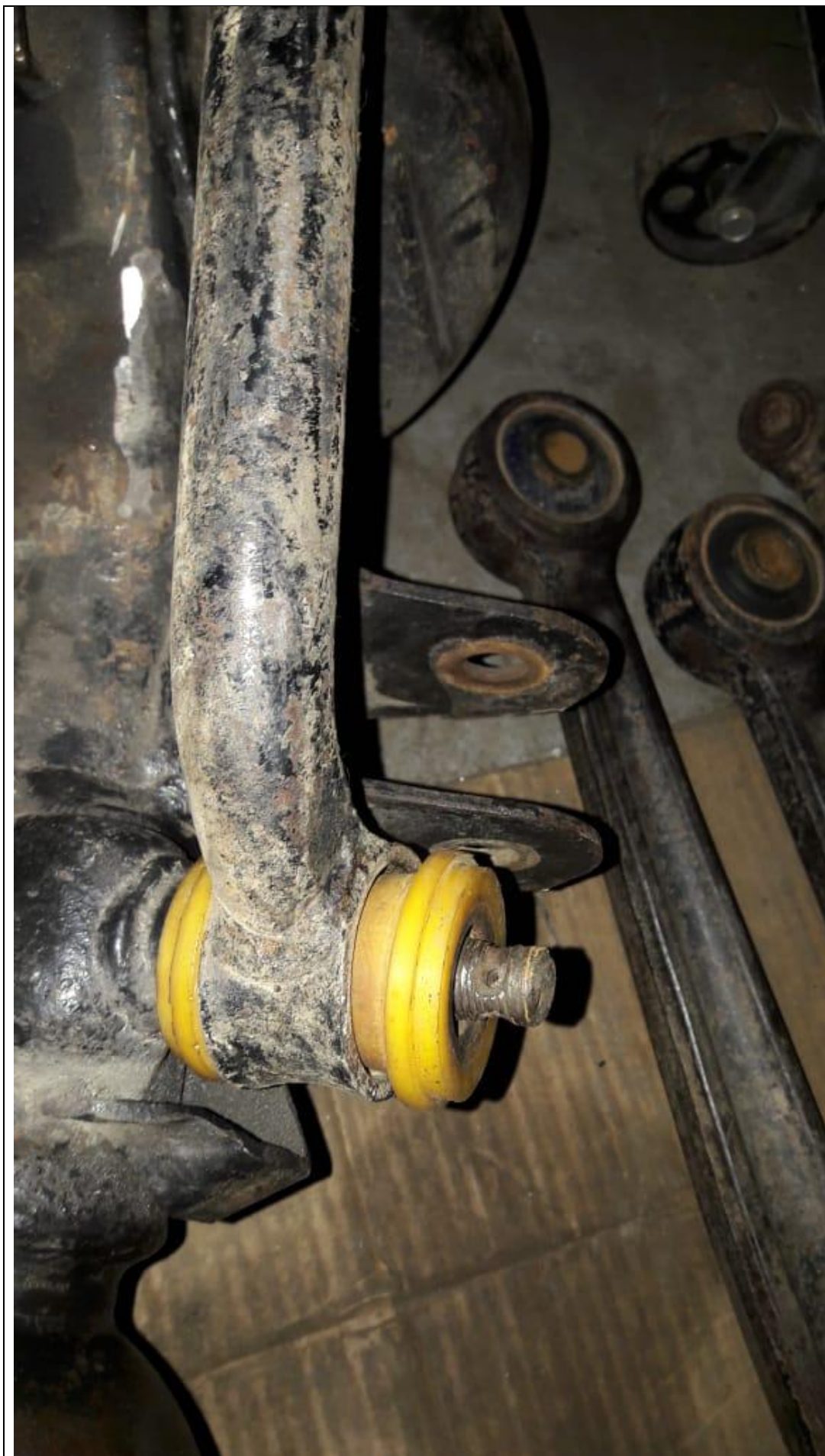
Установленный новый сайлентблок
